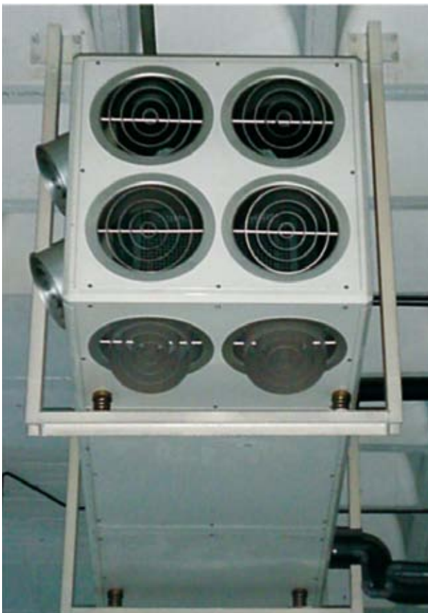
Sistema de ventilación aislada con VIBRABSORBER®
