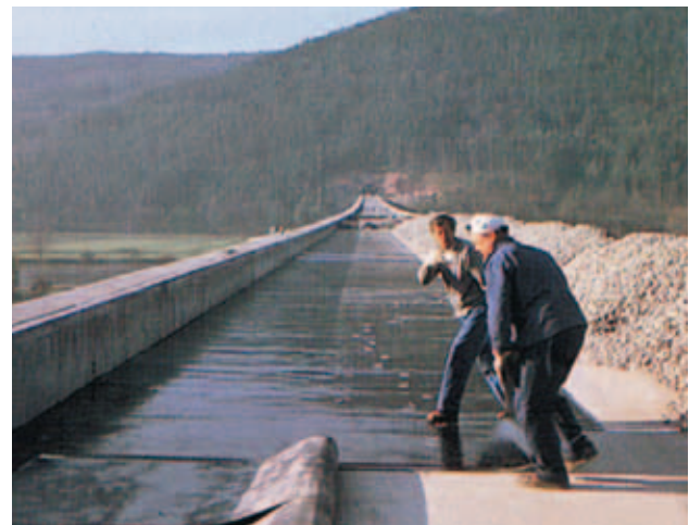
Instalación de SYLOMER bajo balasto en una vía férrea
