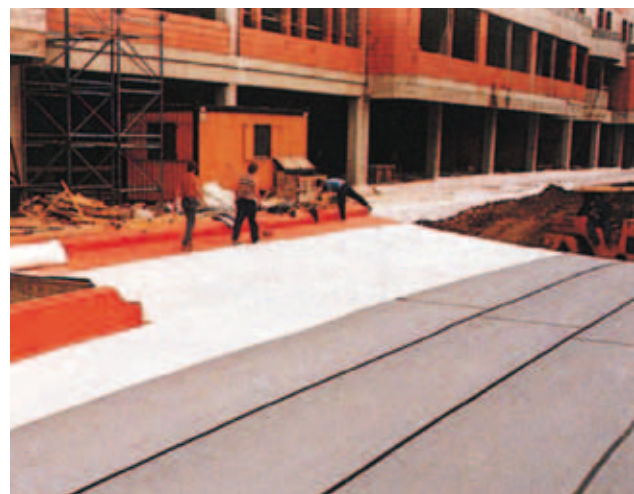
Suspensión flotante de un edificio con SYLOMER
