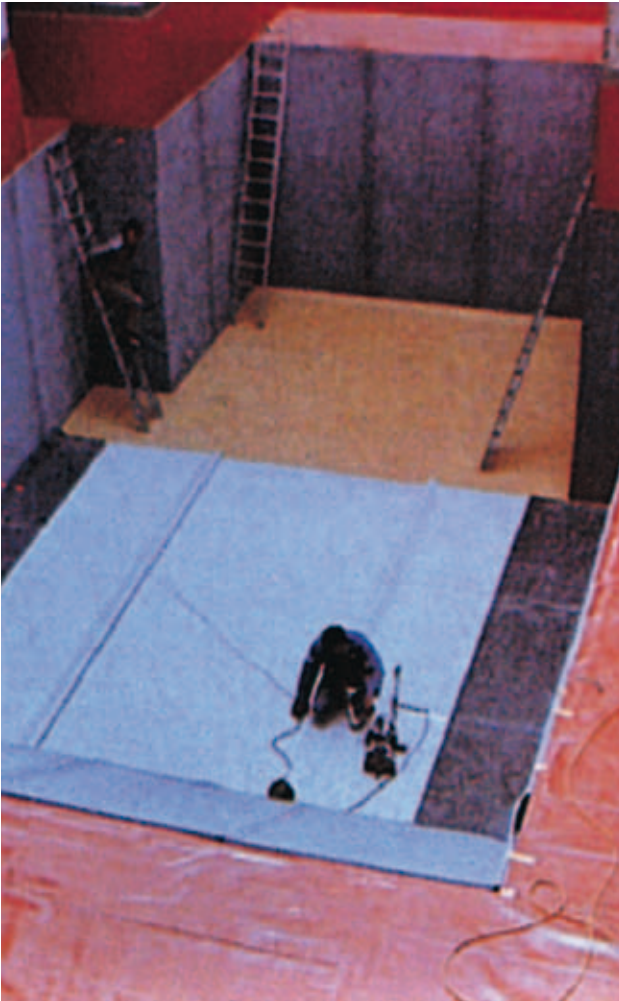
Instalación de SYLOMER para la fundación de una máquina
