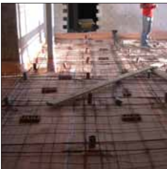
Colocacion del mallazo y hormigonado.
