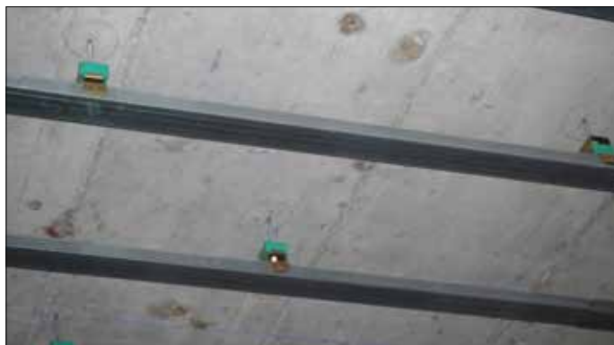
Amortiguadores Akustik Super T60 + Sylomer 30 Tipo B, En estudios de Grabacion HIGAIN USURBIL.
