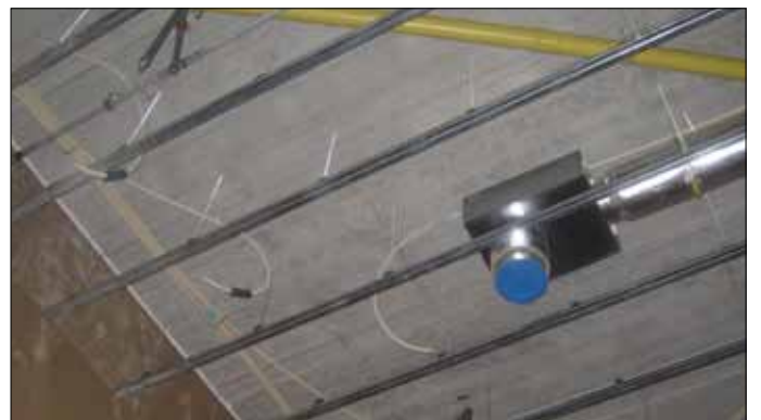
Aplicación del Akustik SUPER T60 + Sylomer 30 tipo B
