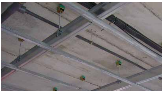
Aplicación de un Akustik 4 + sylomer tipo A
